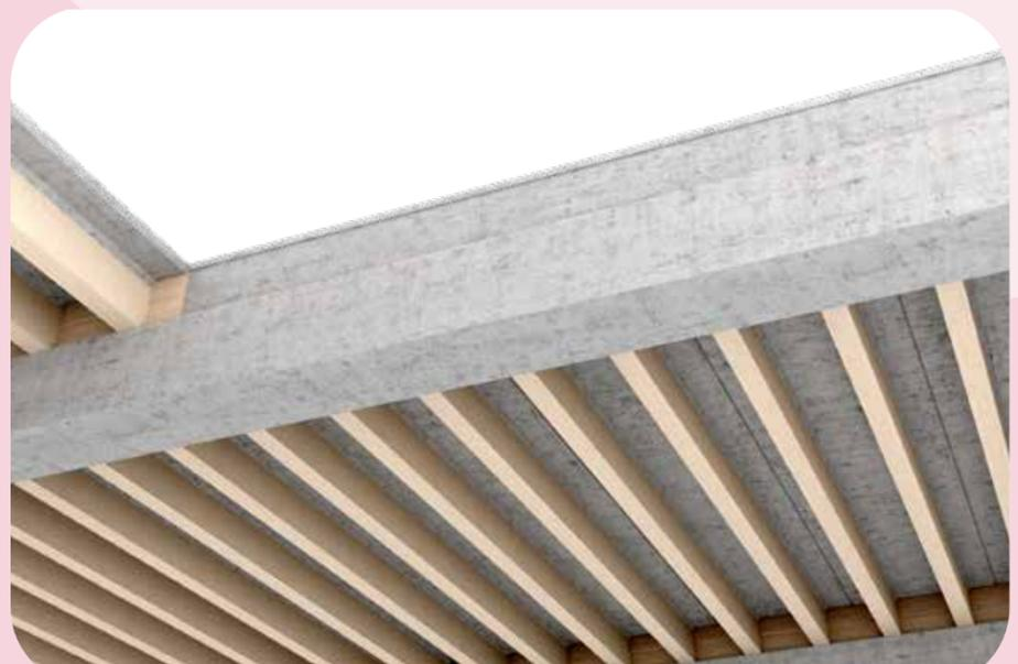
Ejemplo de sistema prefabricado mixto madera-hormigón
