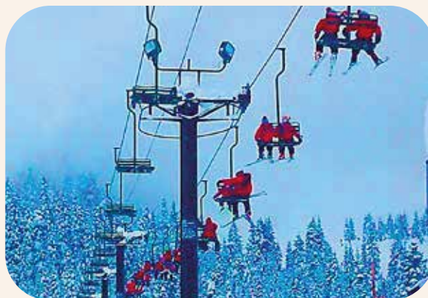
Dispositivos electromagnéticos y de inspección visual se utilizan para encontrar hilos rotos u otros daños, en los cables que se utilizan en aerosillas, grúas y otros aparatos de elevación.
