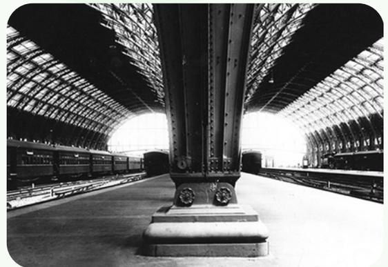
Columna de la estación de trenes Retiro (CABA) del Ferrocarril Mitre, en chapa de acero remachada.
